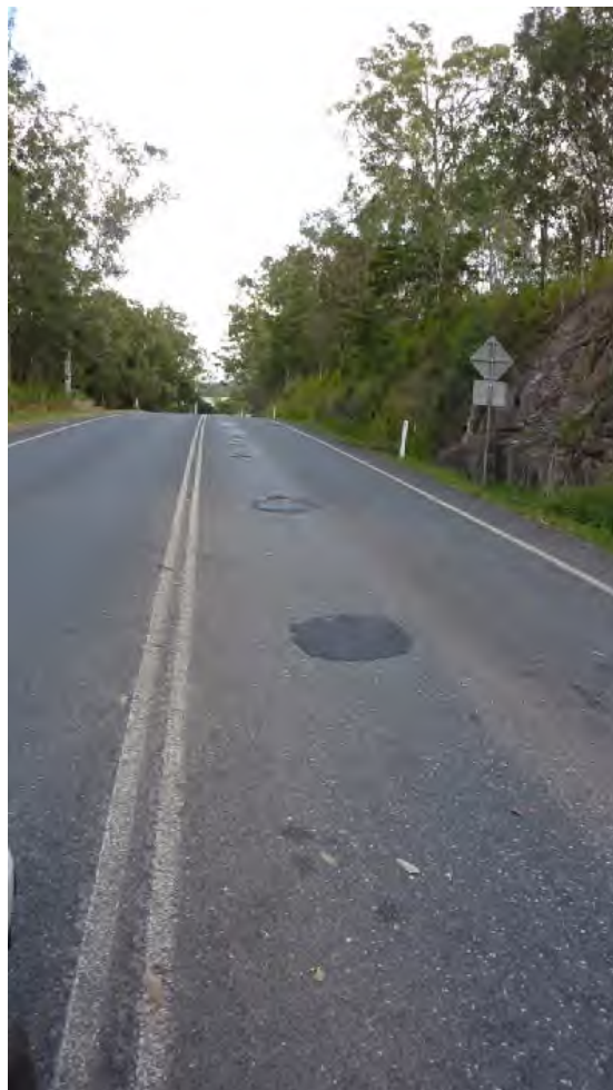
Pavement Fatigue
