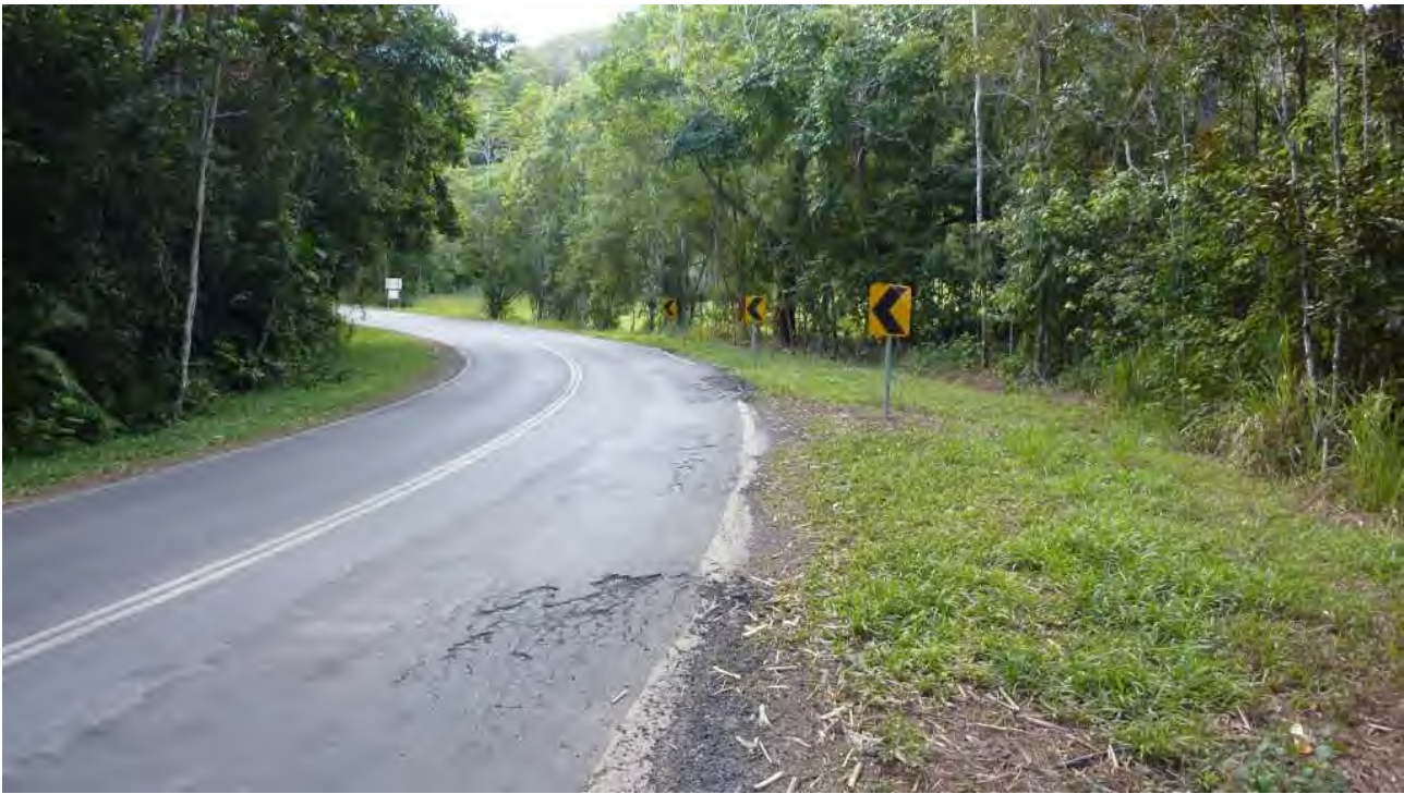
Pavement Fatigue
