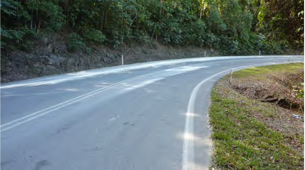
Material Spill Residue
